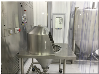
Sistema di svuotamento sacchi manuale collegata ad un sistema di trasferimento polvere
